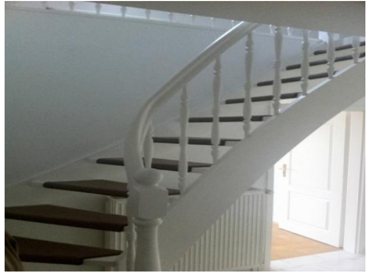
Treppe in den oberen Bereich
