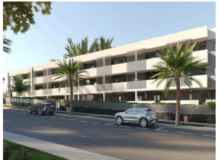
Blick von der Straße aus
