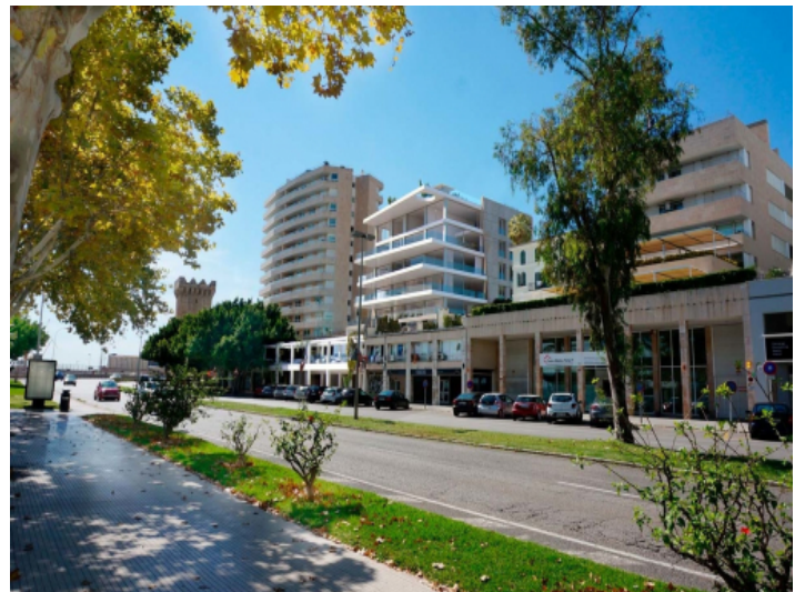
Ansicht des Gebäudes
