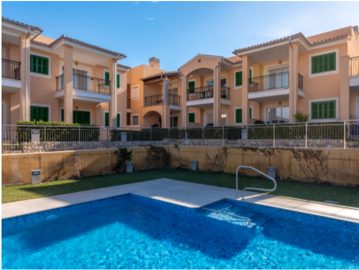
Anischt der Anlage und Pool
