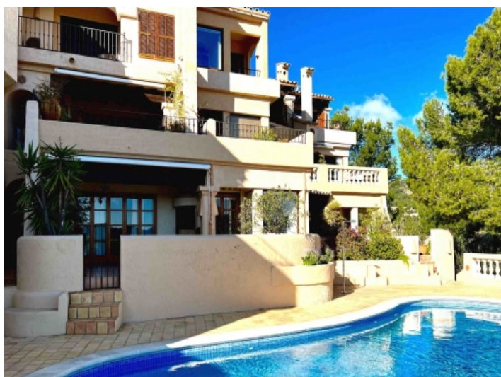
Außenansicht der Wohnanlage
