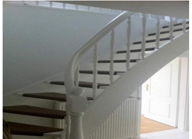
Treppe in den oberen Bereich
