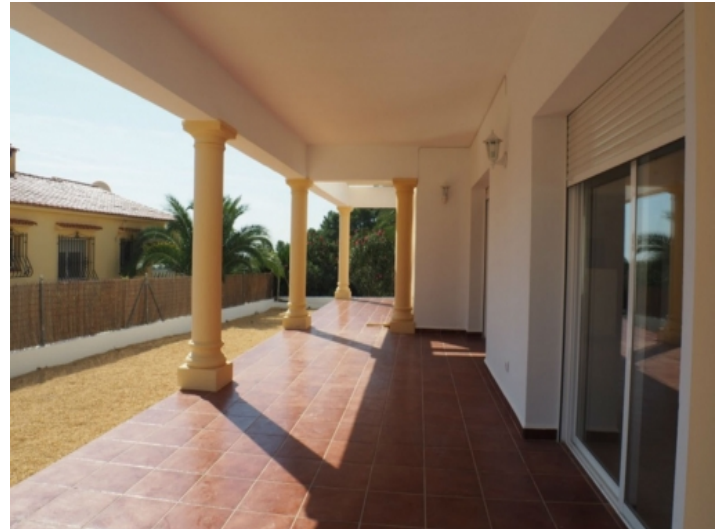
Überdachte Terrasse und Garten
