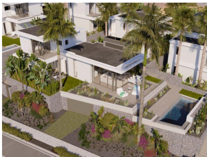
Außenansicht der Villa
