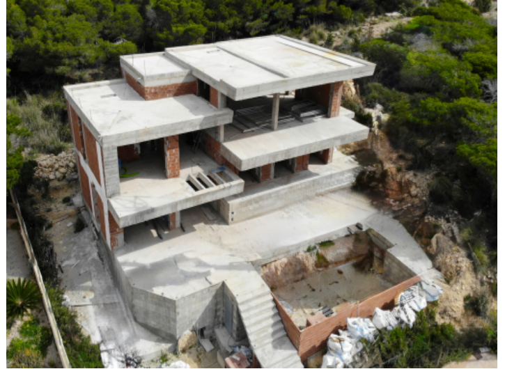
Villa im Rohbau
