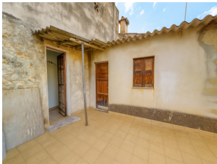
Terrasse des Obergeschosses
