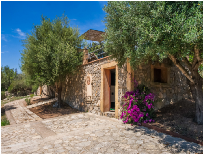
Maschinenraum unter dem Pool
