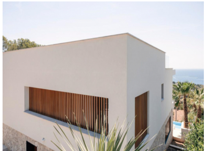
Ansicht auf die Villa
