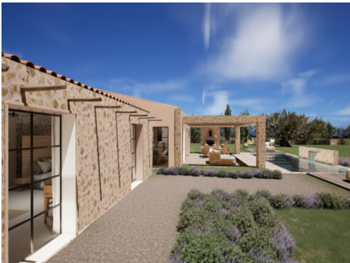
Ansicht auf die hintere Fassade und Garten
