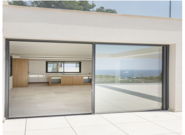
Ansicht von Aussen auf den Wohnbereich mit Küche
