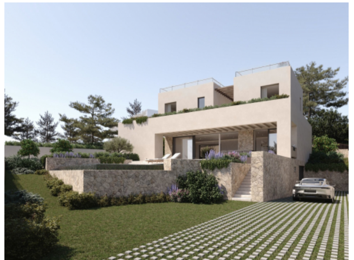
Ansicht auf die Fassade
