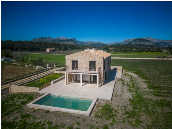
Natursteinverkleidete Finca mit Pool
