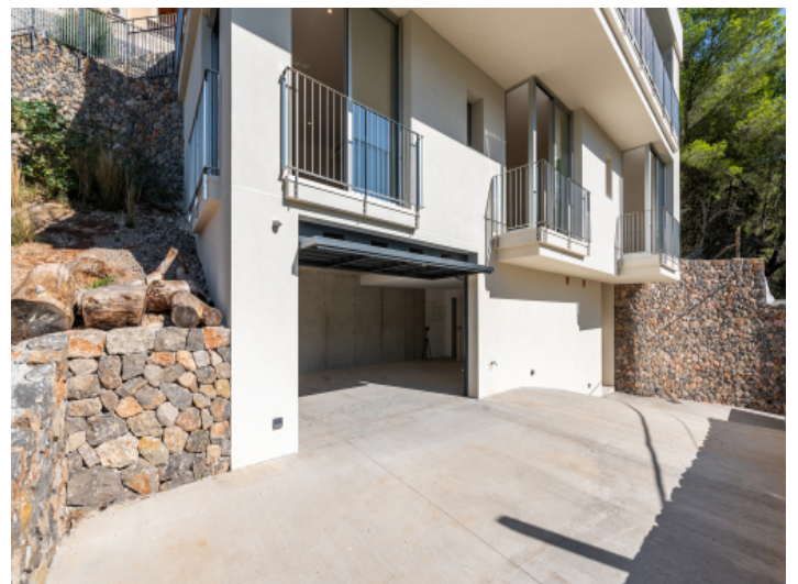
Zufahrt zur Garage
