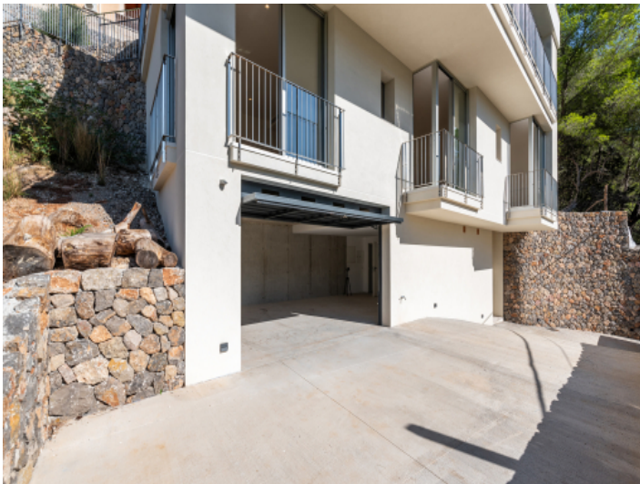
Zufahrt zur Garage
