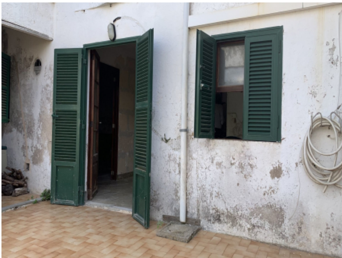
Terrasse des Hauses
