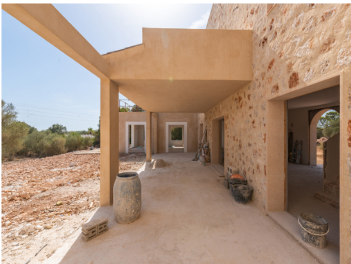
Terrasse im Erdgeschoss
