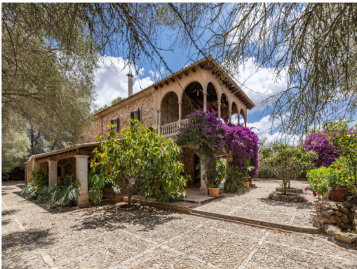
Fassade der Finca
