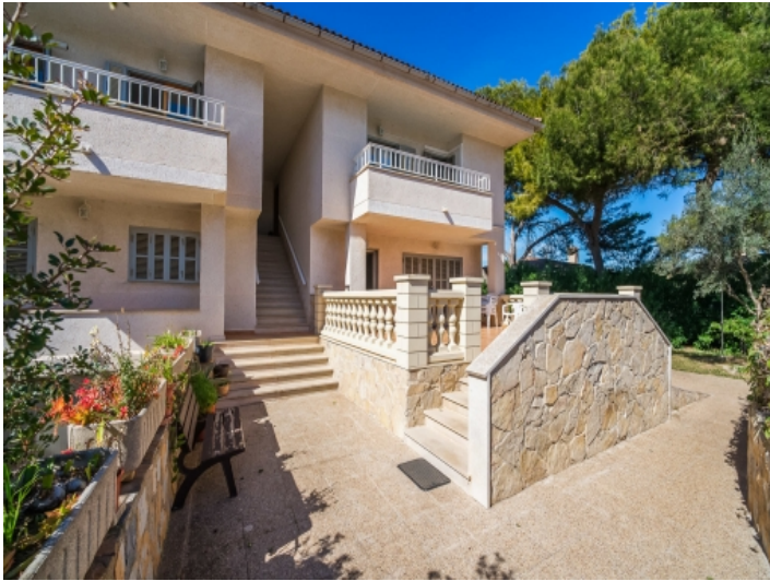
Haus, Playa de Muro
