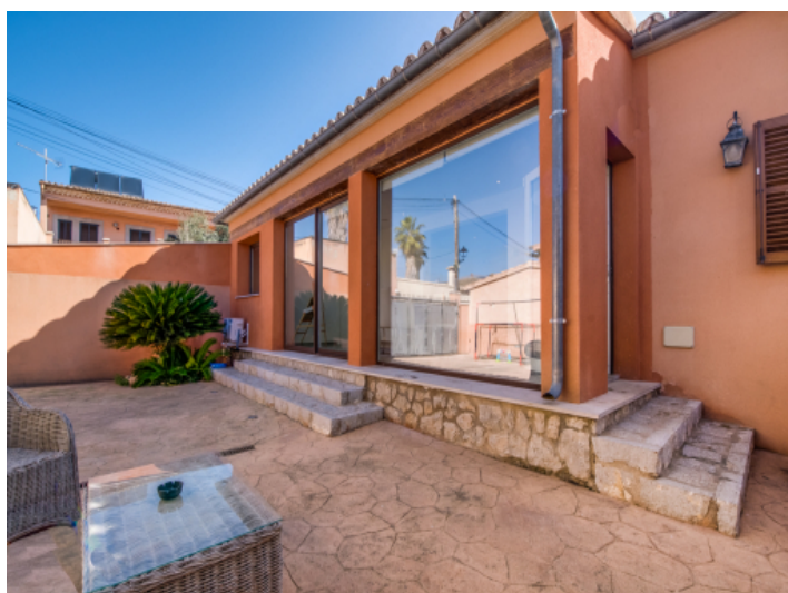
Patio und Zugang zum Essbereich
