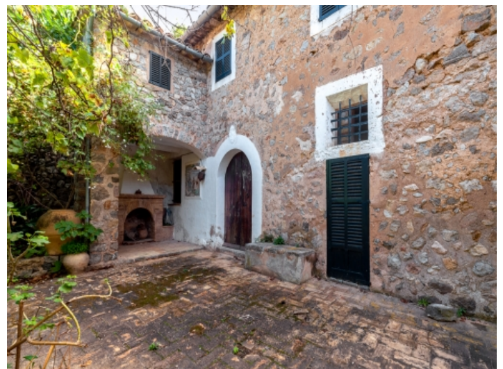
Ansicht der Natursteinfassade
