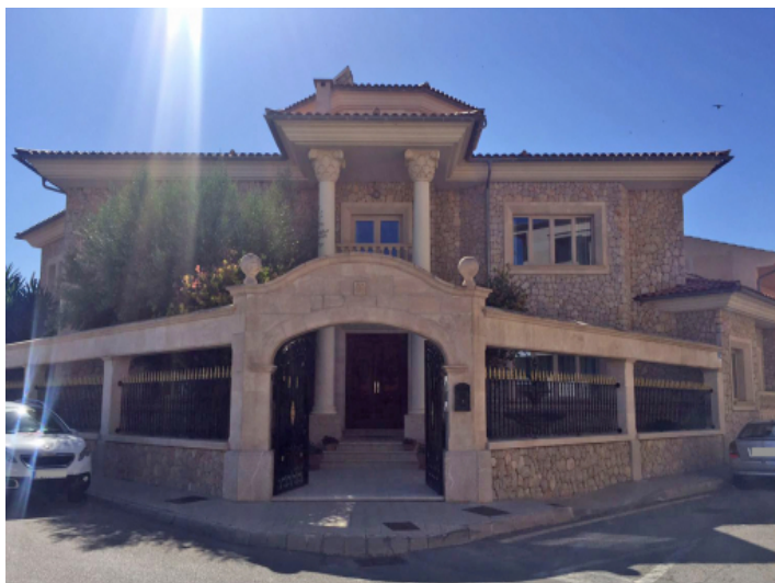
Straßenansicht der Villa
