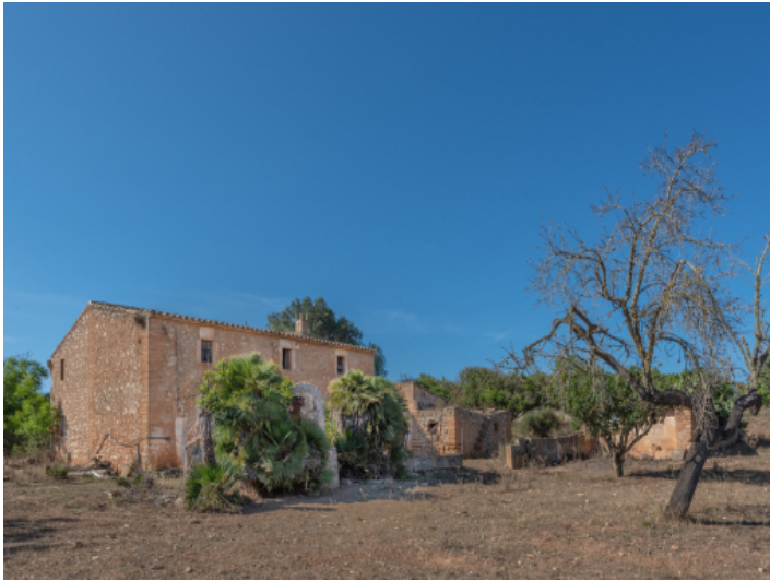
Historisches Finca Anwesen zum Sanieren in Sant Llorenç des
