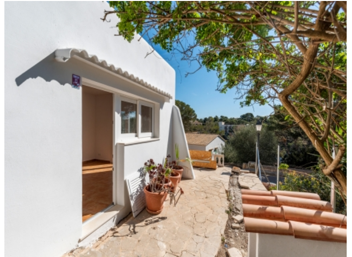
Zugang zum zweiten Bungalow
