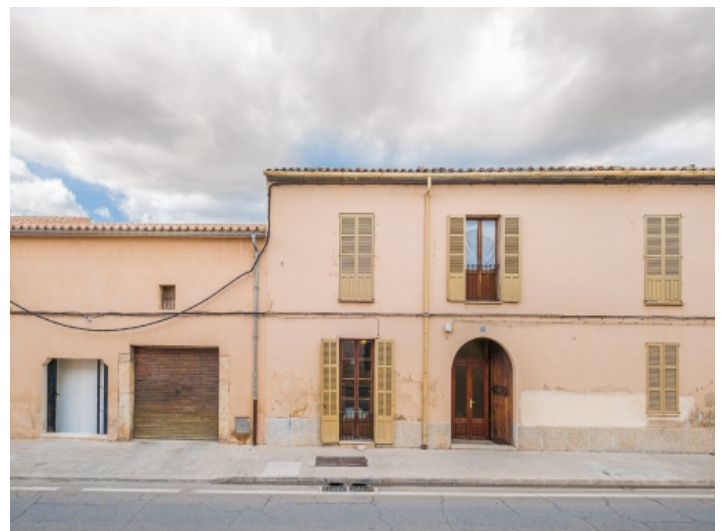
Außenansicht von der Straße
