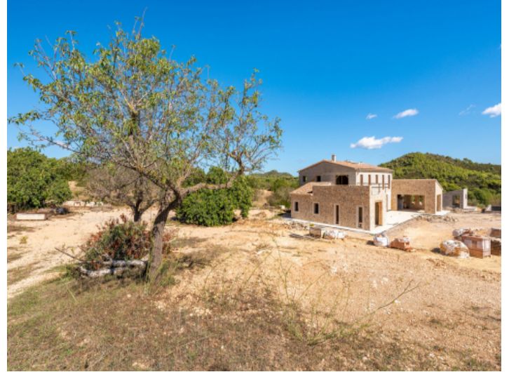
Außenansicht der Finca
