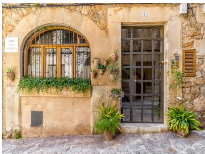
Einladender Zugang zum Haus
