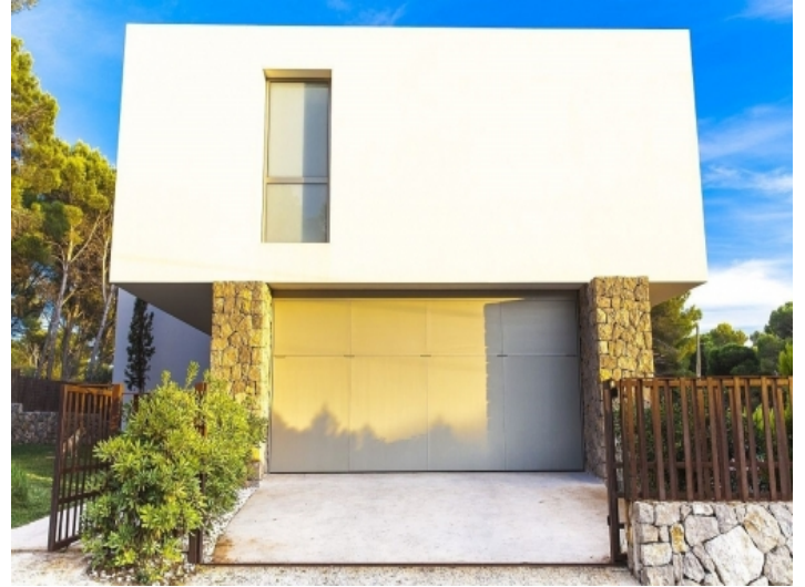
Zufahrt zur Garage
