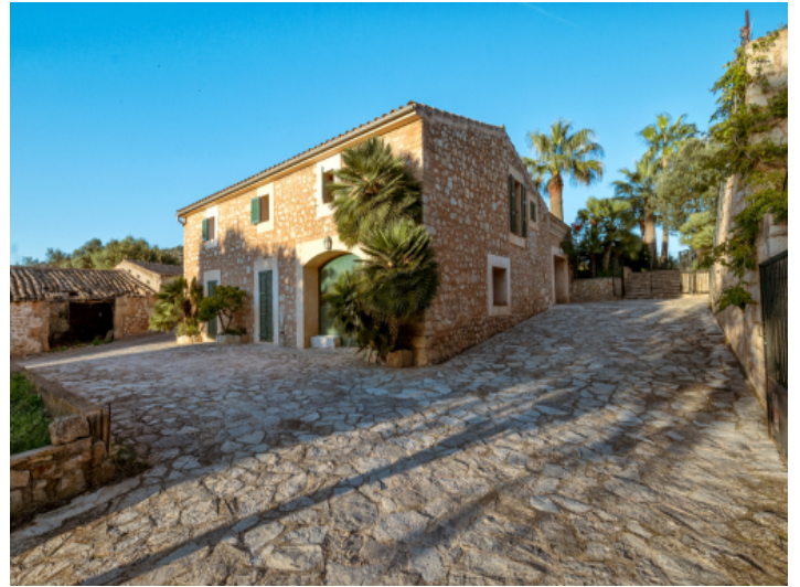
Außenansicht eines Seitengebäudes
