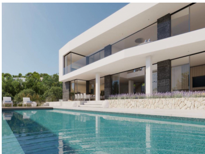
Außenansicht mit luxuriösem Poolbereich
