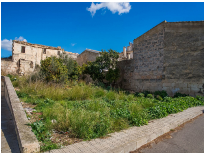
Blick von der Südseite
