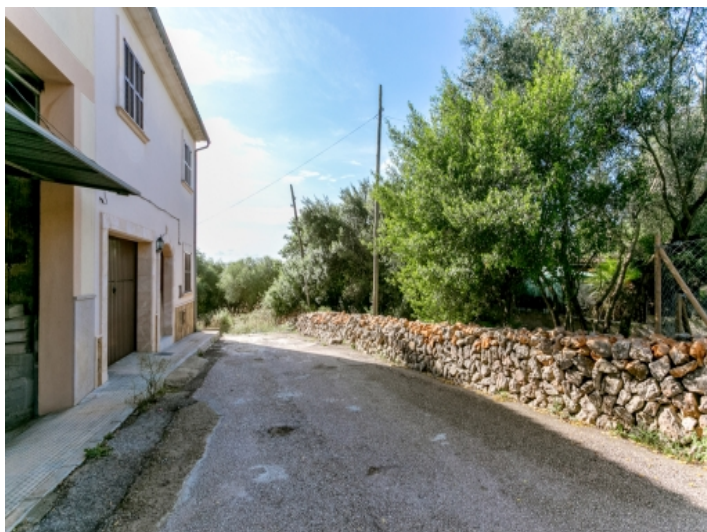
Das Grundstück ist ruhig gelegen
