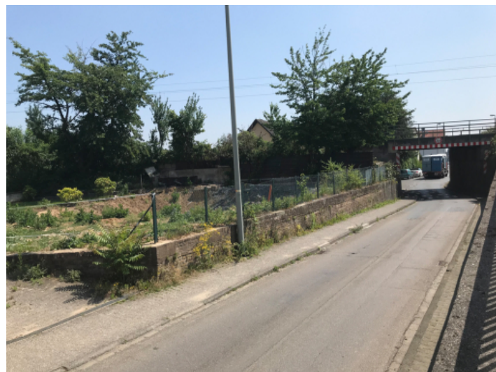
Blick zum Tunnel
